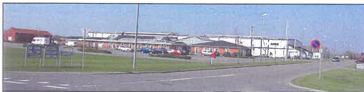
Den østlige side af lokalplanområdet ved krydset Messevej/Vestre Boulevard
