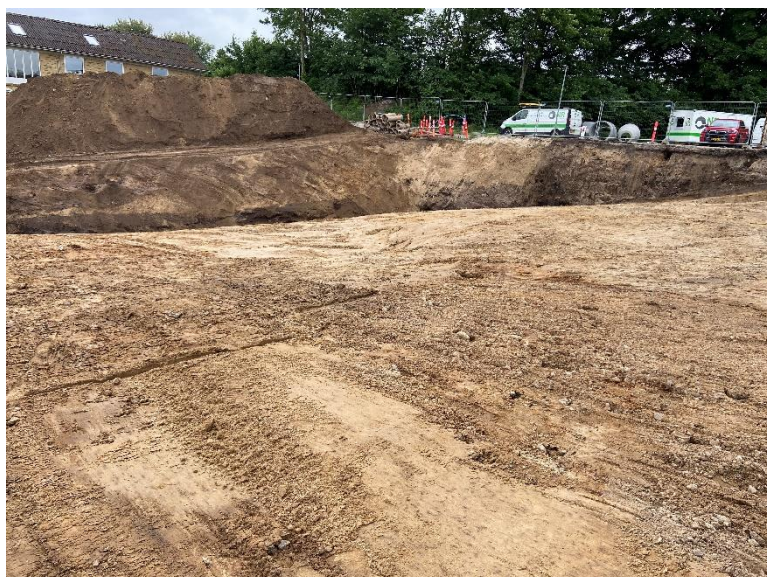
Foto 2. Udgravningsniveau set fra nord.
