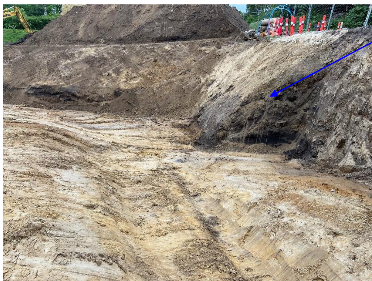
Foto 3. Udgravningssiden mod vest, hvor der manglede at blive afrømmet en mindre del.
