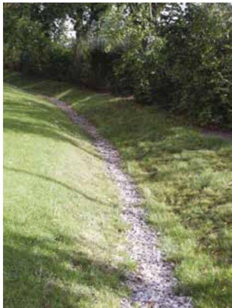
Illustration 12: princip om trug/grøfter/lavninger.
