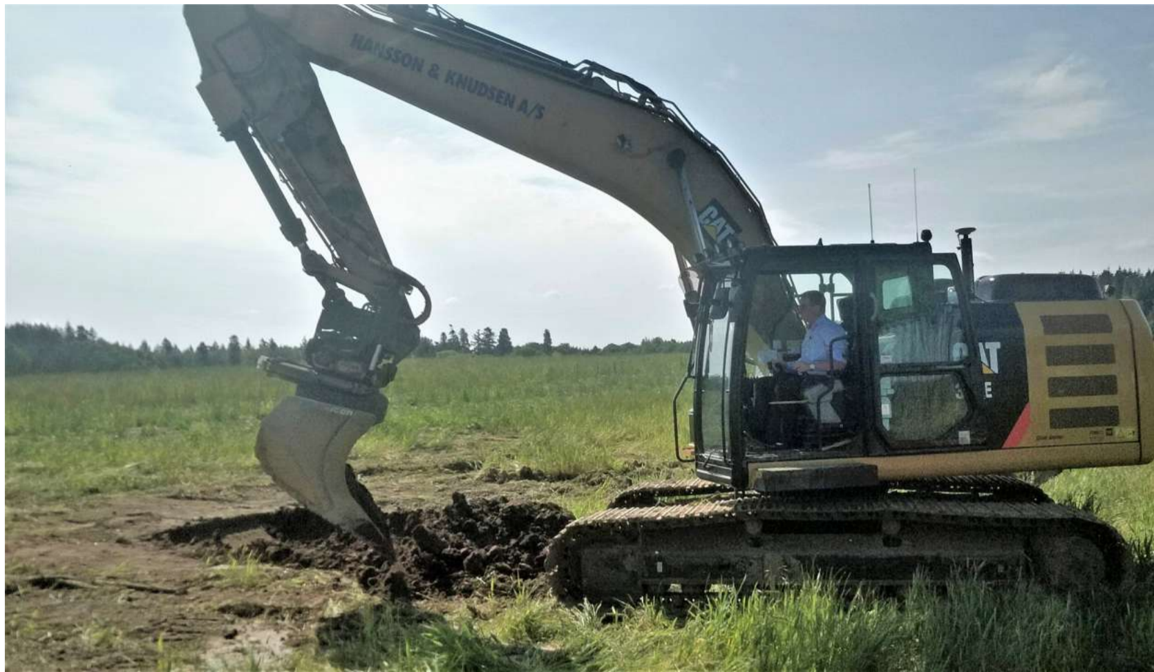
Onsdag formiddag tog borgmester Morten Andersen (V) første spadestik til de nye byggegrunde, der skal byggemodnes i Morud. Foto: Martin Ytting Rask
