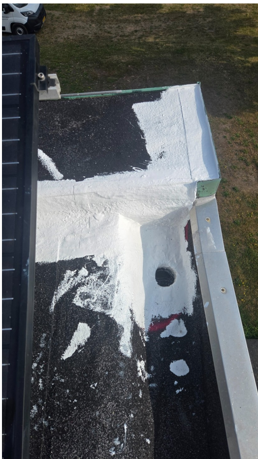
Under udførelse: Væv og membran ført omkring nedløbet.
