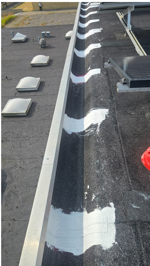
Under udførelse: Samlinger i skotrenden forstærket med væv og membran.
