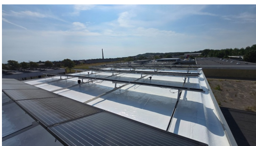
Efter: Behandlet tagflade set langs solcellekonstruktionerne.
