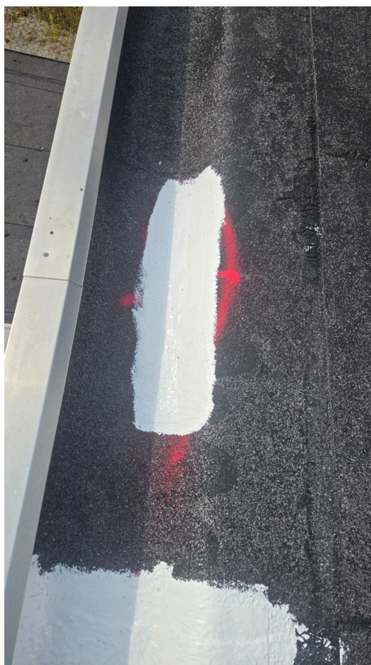
Efter: Mindre dampbule afsluttet med membran og vævforstærkning.
