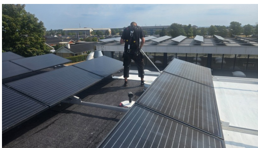
Under udførelse: Påføring af hvid silikone-tagmembran mellem solcellekonstruktionerne.
