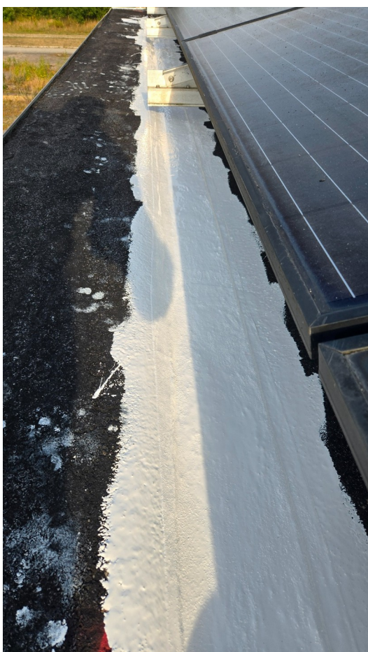
Under udførelse: Samlingen forstærkes sammenhængende med væv og membran.
