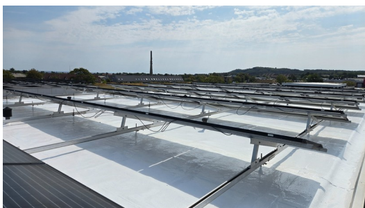
Efter: Sammenhængende membranflade mellem og under solcellekonstruktionerne.
