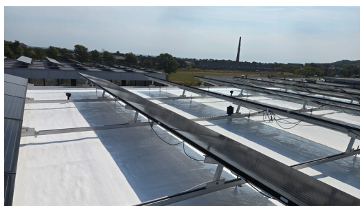
Efter: Færdigt tagområde med sammenhængende membranflade.
