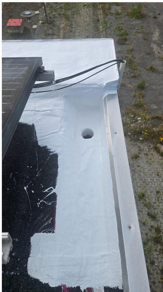
Efter: Området omkring nedløbet og overgangen ned i afløbet er forstærket.
