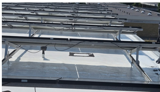
Under udførelse: Behandlede felter mellem solcellekonstruktionerne.
