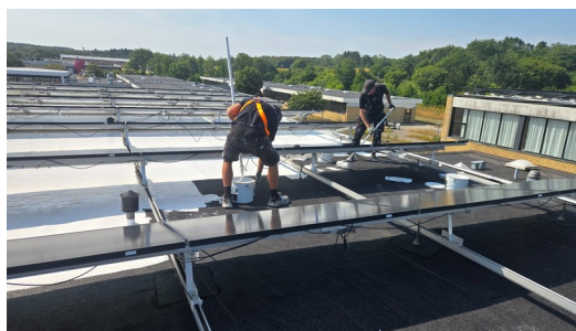
Under udførelse: Membranarbejde udføres mellem solcellekonstruktionerne.
