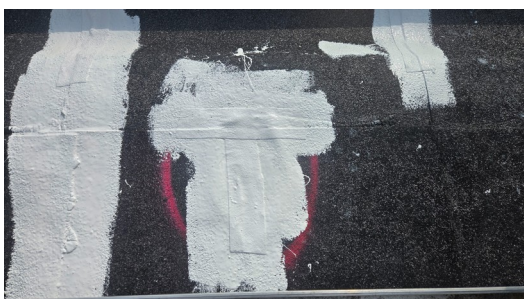
Efter: Den store dampbule afsluttet med væv og membran.
