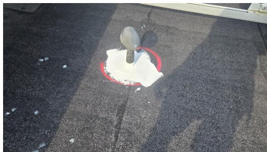
Efter: Større airlift afsluttet med væv og membran.
