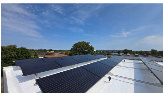
Efter: Færdig membranflade omkring solcelleanlægget.
