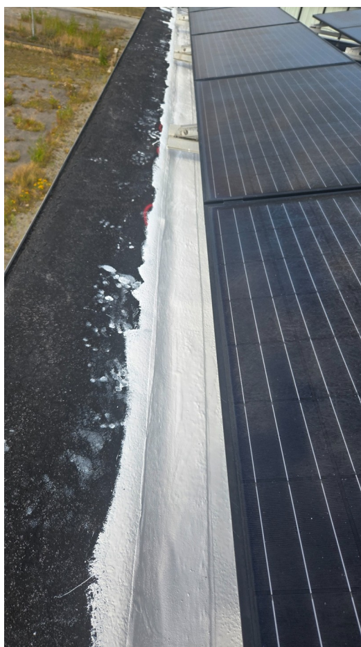
Efter: Samlingsforløbet ved murkronen afsluttet fra side til side.
