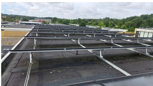
Før: Samlet overblik over tagfladen under solcelleanlægget.
