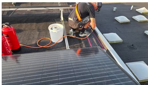
Under udførelse: Den løse tagpap ved den store dampbule fastbrændes.
