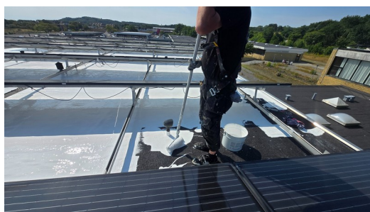
Under udførelse: Membranen udlægges i sammenhængende felter.
