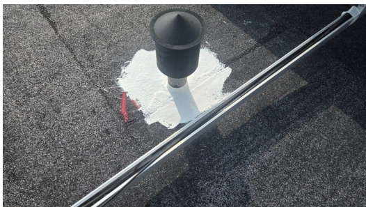
Efter: Mindre airlift forstærket med væv og membran.
