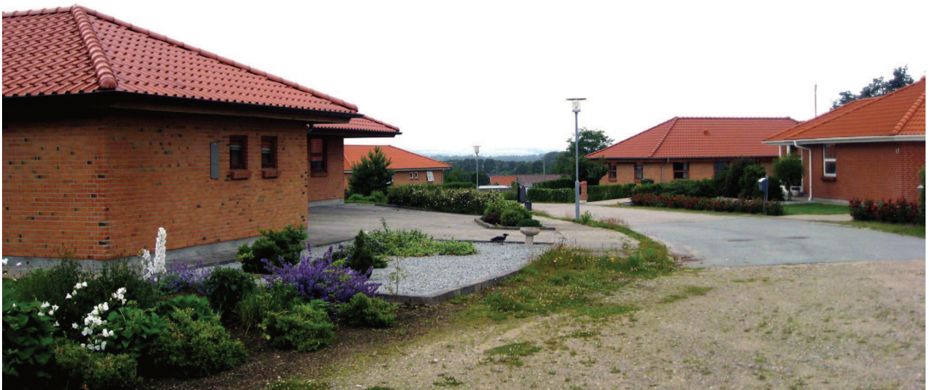
Eksisterende bebyggelse på Bakkevænget.
