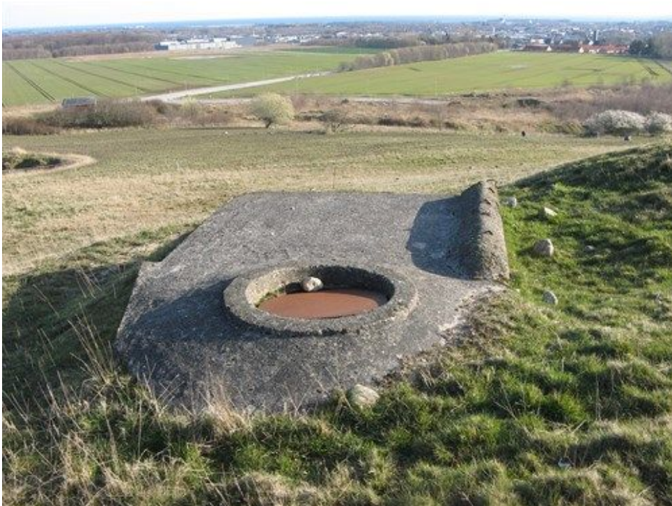
Rester fra bunkersanlæg fra 2. verdenskrig.
