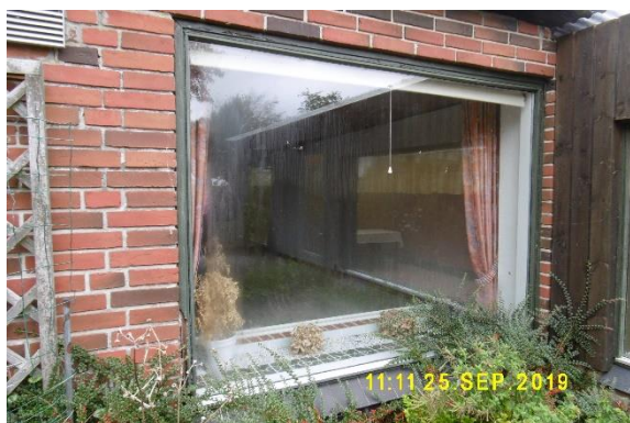
Billede 5: Stuevindue (med rådangreb)
