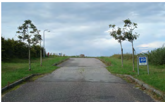
Hastighedsdæmpende indsnævring af vejen (Overgårdsallé)
